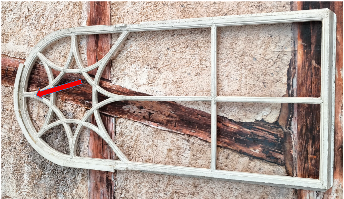
Abbildung 16: Fensterrahmen mit ‚Hakenblatt‘ in der Bogenkonstruktion
