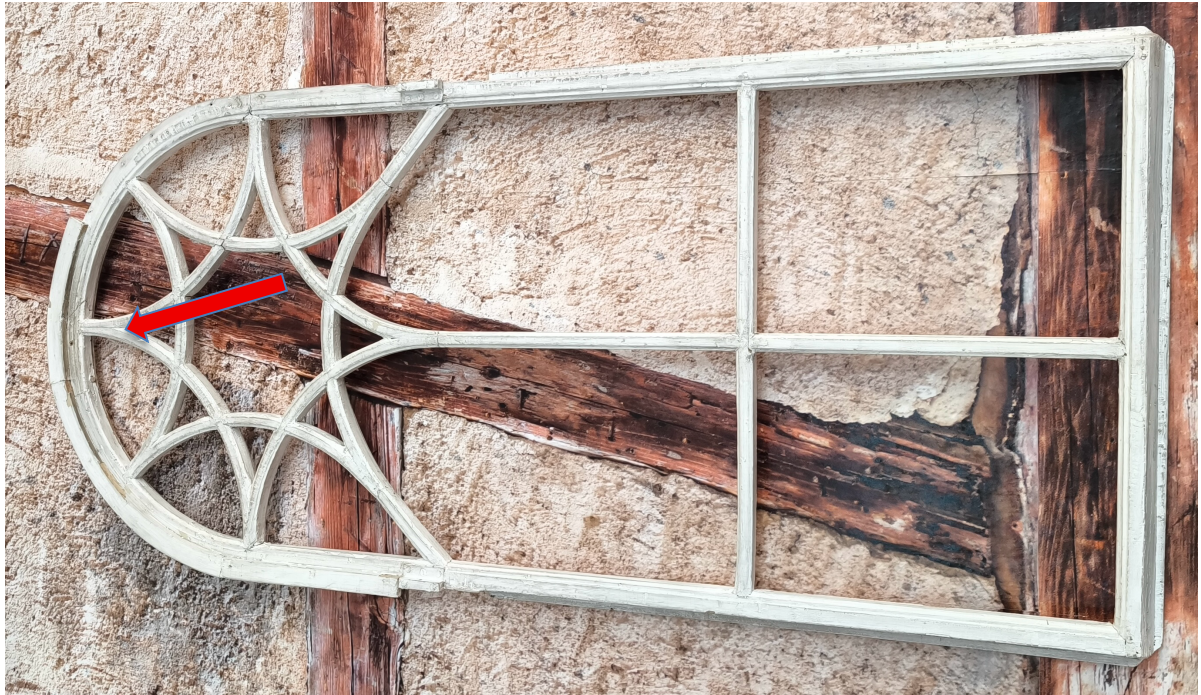
Abbildung 16: Fensterrahmen mit ‚Hakenblatt‘ in der Bogenkonstruktion
